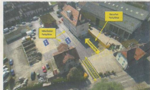
Das neue Verkehrsregime entlastet die Aeschstrasse: Ein- und Ausfahrt beim neuen Hauptsitz der Notter-Gruppe erfolgen neu über die Jurastrasse.
