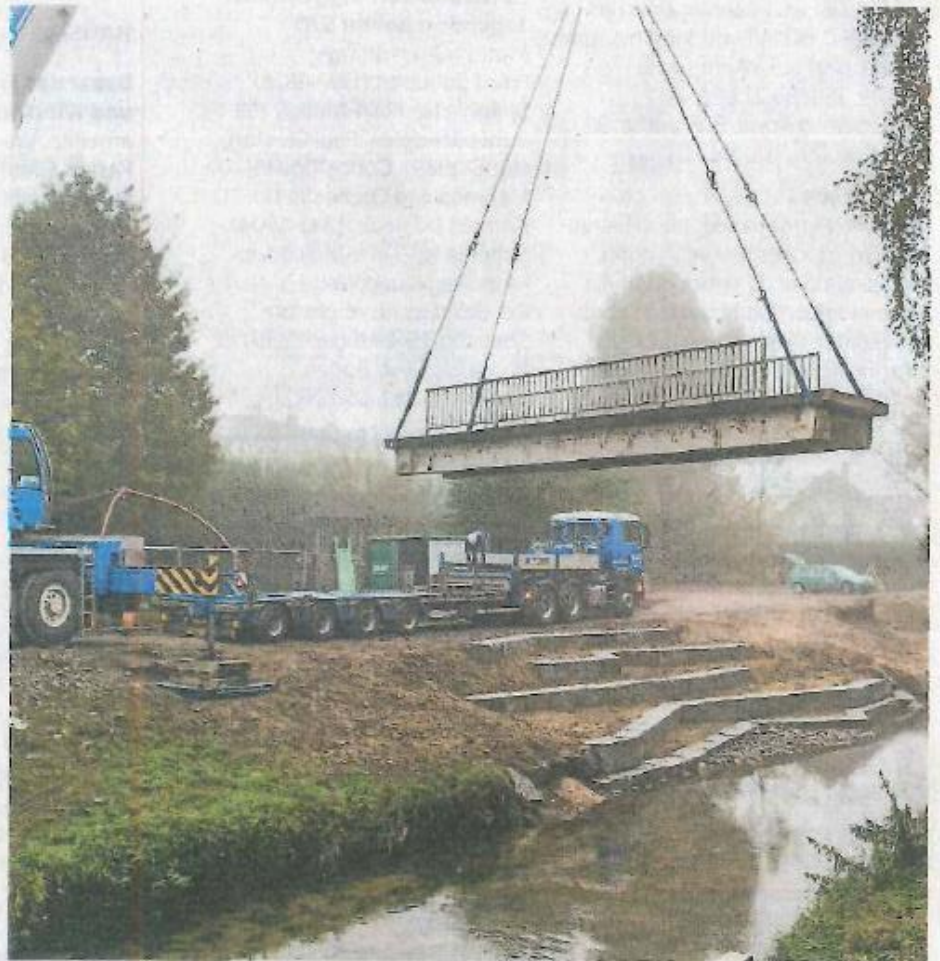
Recycling der anderen Art: Die Brücke wird auf den Sattelschlepper gelegt.
